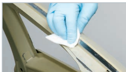
Gyors és megfelelő felület előkészítés
